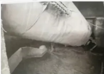
倾倒后的锅炉筒体
